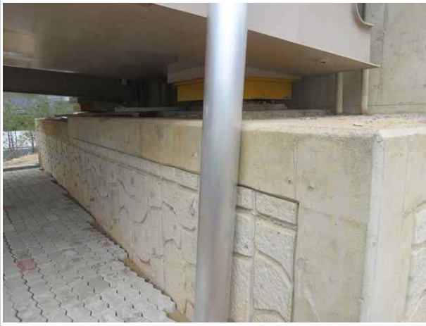
교대 A1 전경
