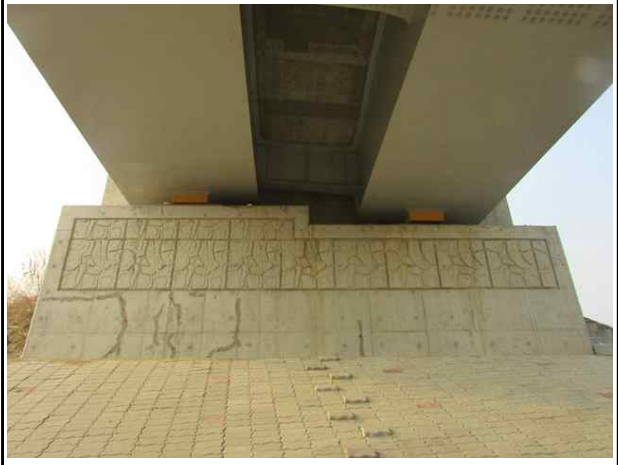
교대 A2 상태양호
