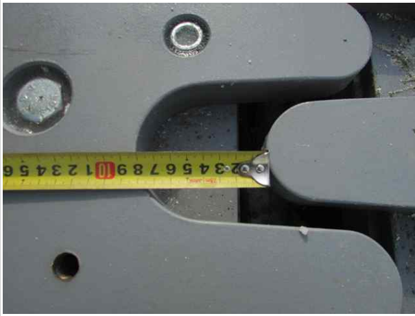
신축 유간거리 측정전경
