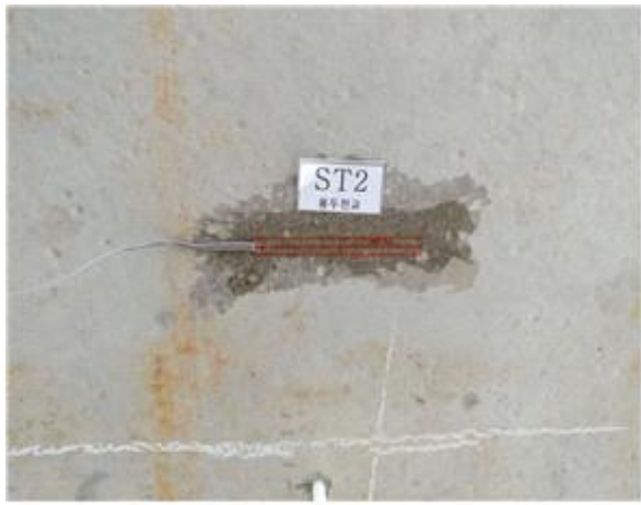
변형률계 설치 현황
