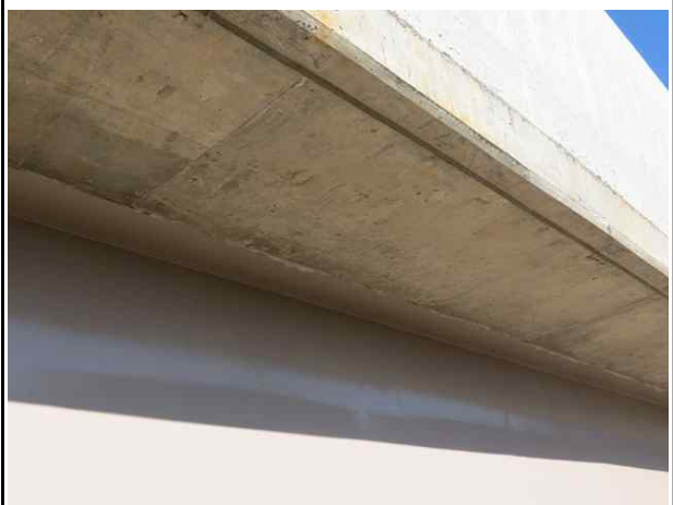
바닥판 하면 캔틸레버부 상태양호
