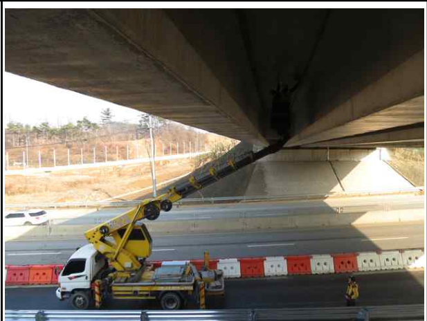
고소점검차를 이용한 바닥판 하부 조사
