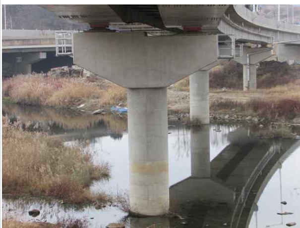
교각 P1 전경
