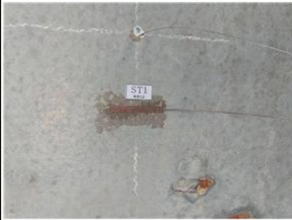
변형률계 설치 현황
