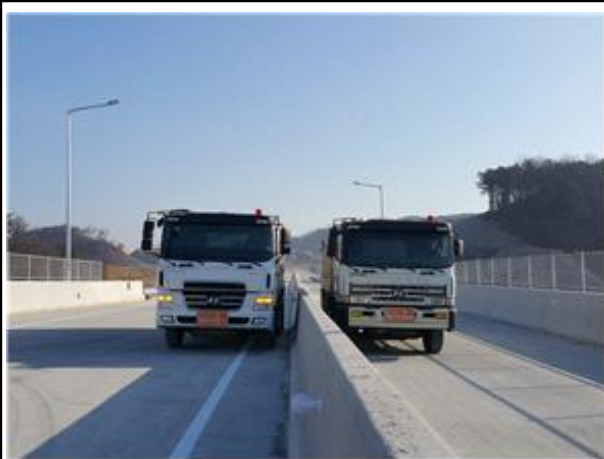
정적 재하시험 전경
