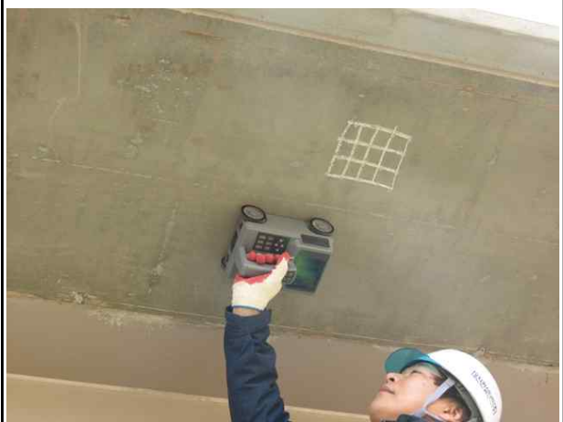
철근배근탐사 시험 전경
