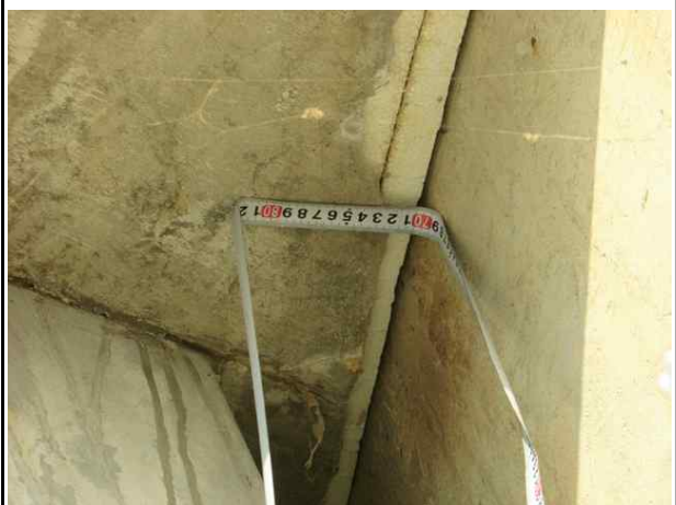
슬래브 유간거리 측정전경
