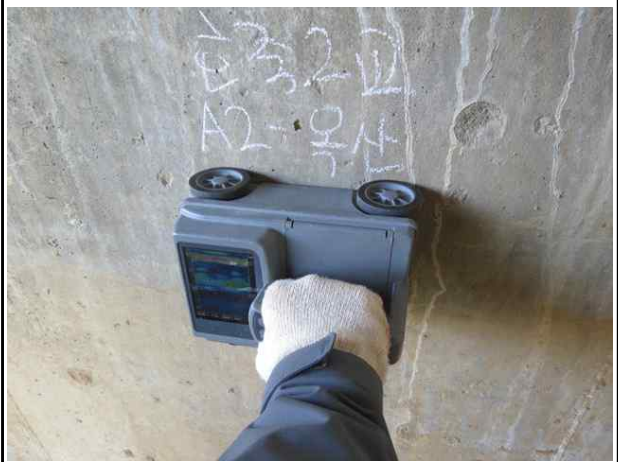
철근배근탐사 시험 전경
