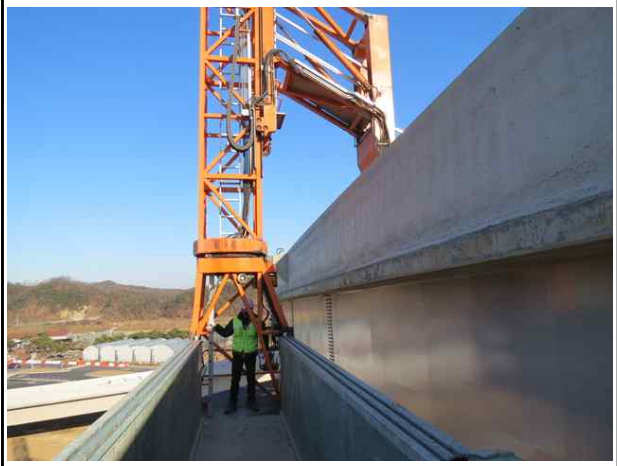
교량점검차를 이용한 바닥판 하부 조사
