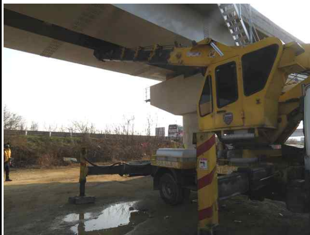
고소점검차를 이용한 바닥판 하부 조사
