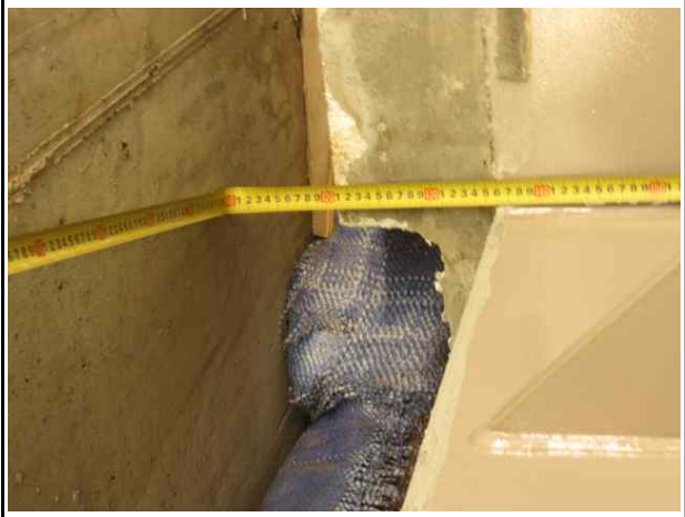
슬래브 유간거리 측정 전경
