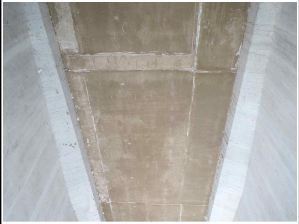
바닥관 하면 상태양호(오창방향)
