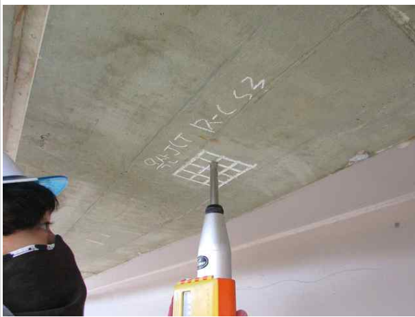
반발경도측정 시험 전경
