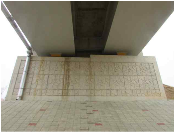
교대 A1 전경
