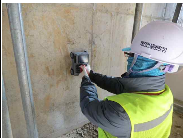
철근배근탐사 시험 전경
