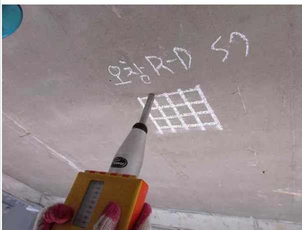
반발경도측정 시험 전경
