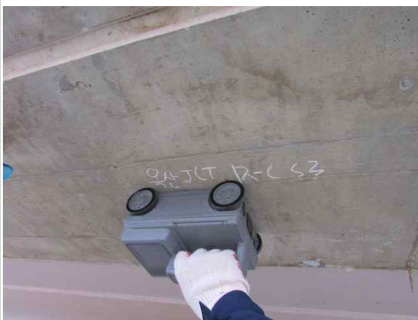
철근배근탐사 시험 전경
