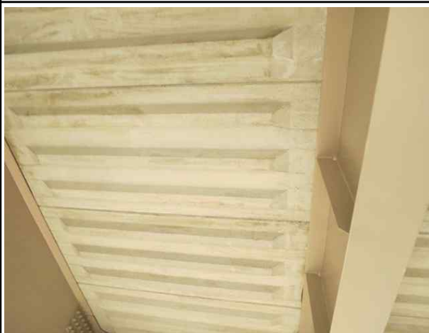
바닥판 중앙부 Rib Dek 상태양호
