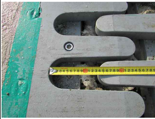
신축 유간거리 측정전경
