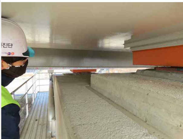
교량받침 연단거리 측정전경
