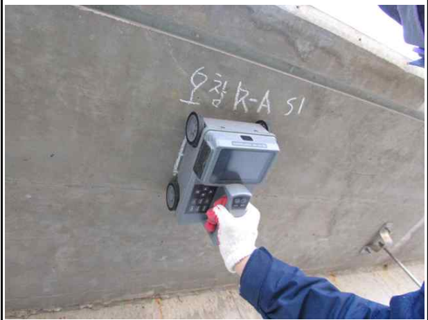
철근배근탐사 시험 전경
