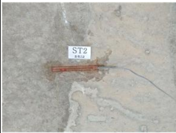
변형률계 설치 현황
