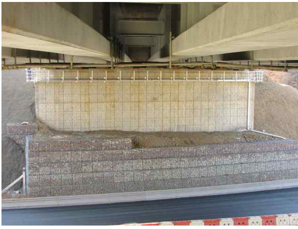
교대 A1 전경(상태양호)
