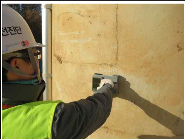
철근배근탐사 시험 전경
