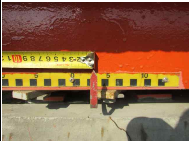
교량받침 이동량 측정전경
