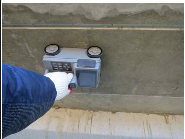
철근배근탐사 시험 전경
