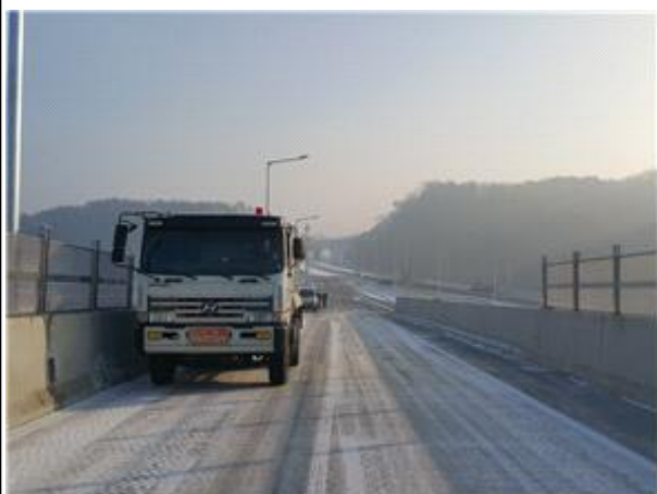
정적 재하시험 전경
