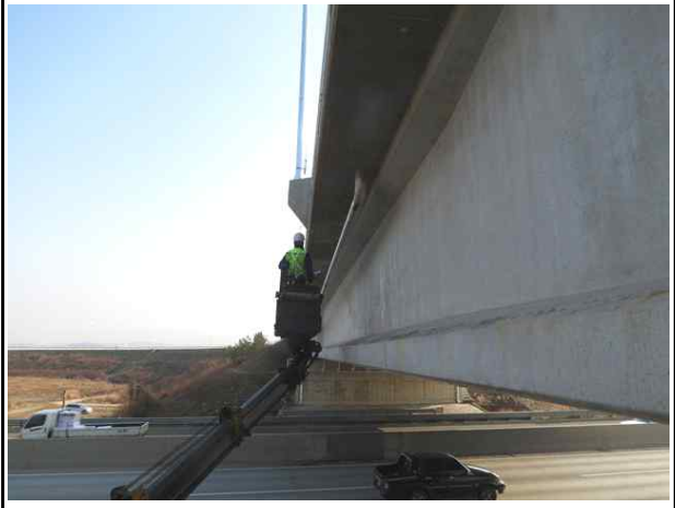
고소점검차를 이용한 바닥판 하부 조사
