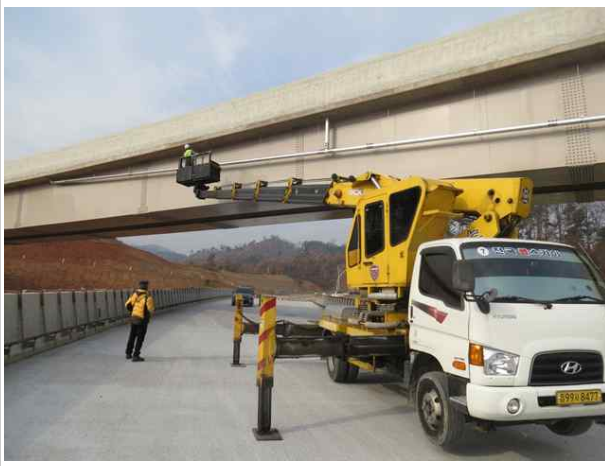
고소 점검차를 이용한 바닥판 하부 조사
