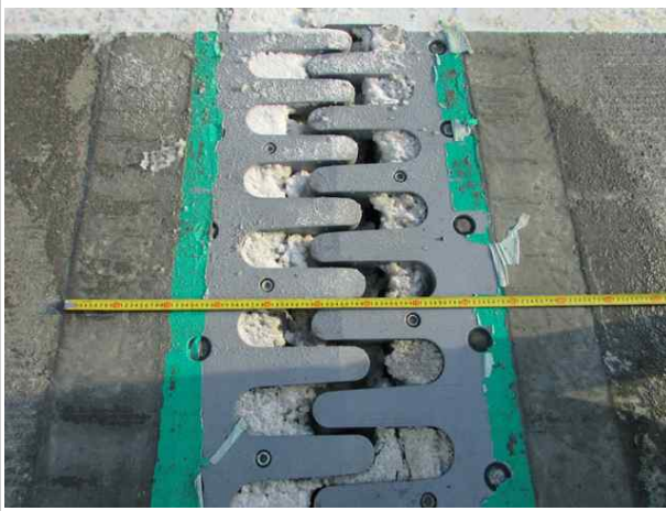
신축 유간거리 측정전경
