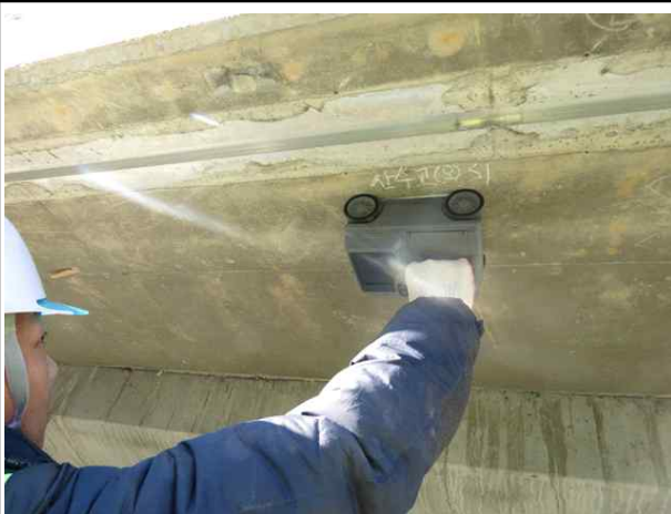
철근배근탐사 시험 전경
