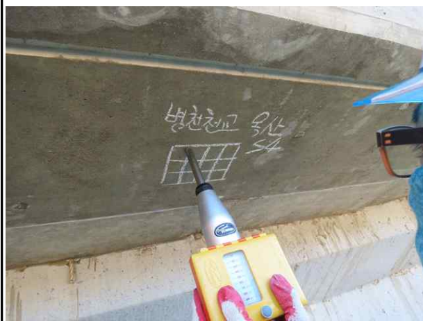
반발경도측정 시험 전경
