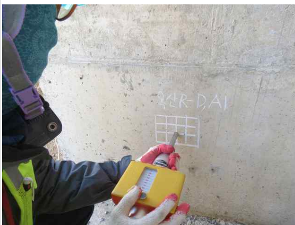
반발경도측정 시험 전경
