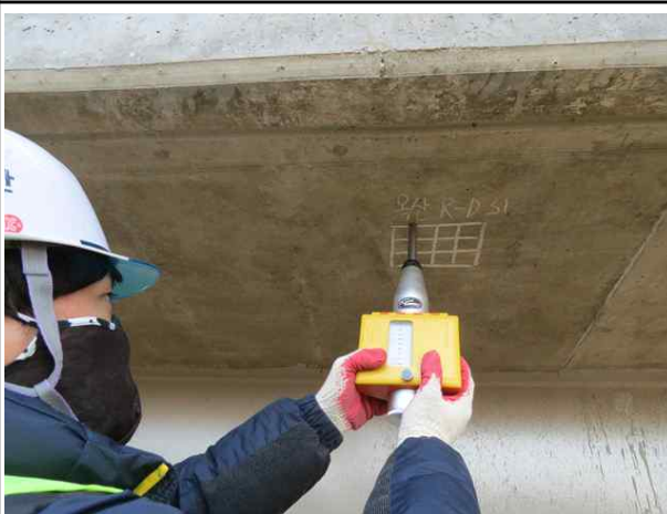
반발경도측정 시험 전경
