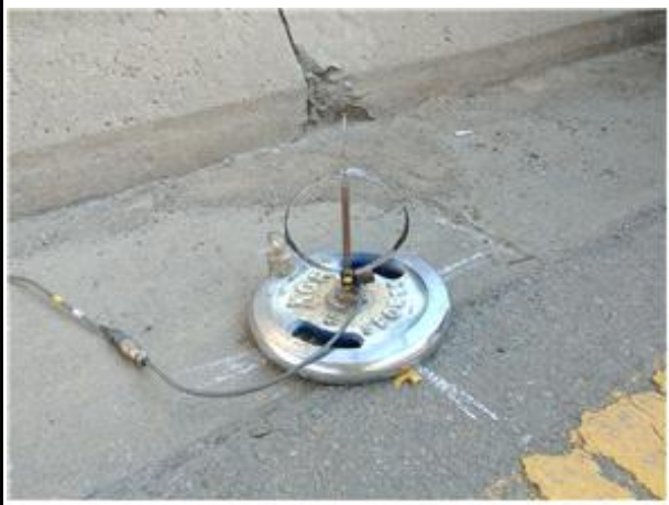
처짐계 설치 현황
