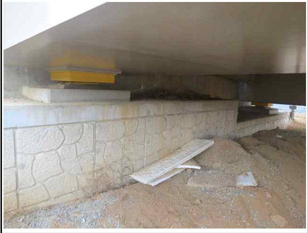
교대 A2 전경
