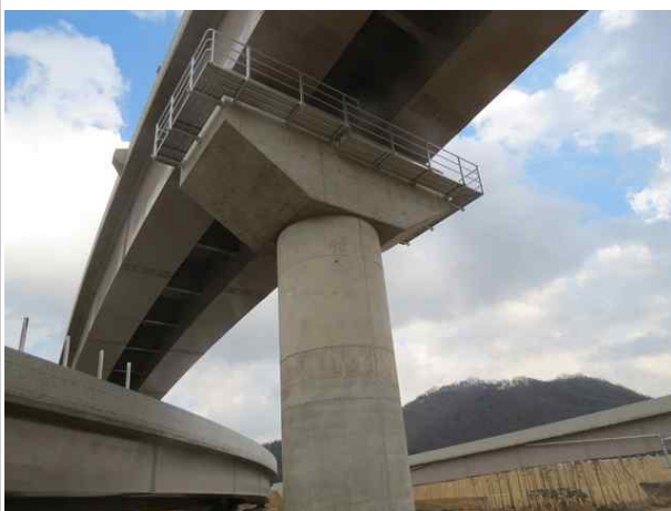
교각 P1 전경
