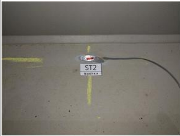
변형률계 설치 현황
