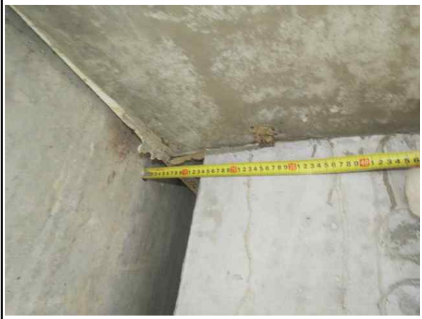
슬래브 유간거리 측정전경
