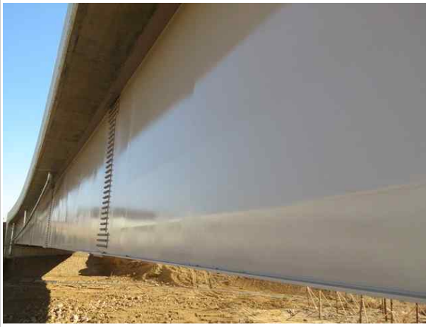
강재 거더 외부 상태양호
