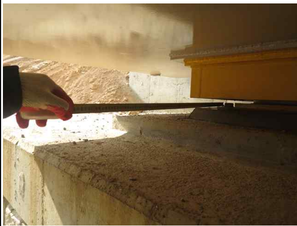
교량받침 연단거리 측정전경
