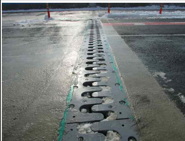
신축이음 상태양호(A1, 옥산방향)
