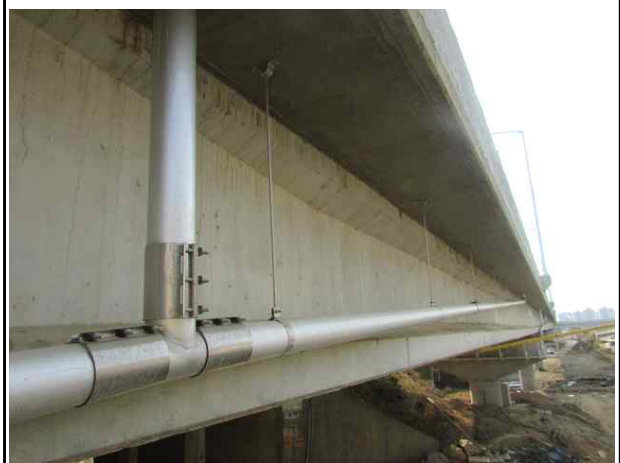
배수관 설치상태 양호
