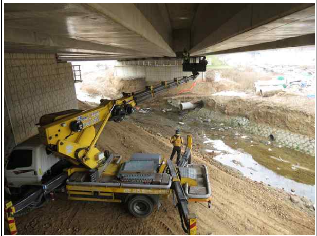
고소점검차를 이용한 바닥판 하부 조사
