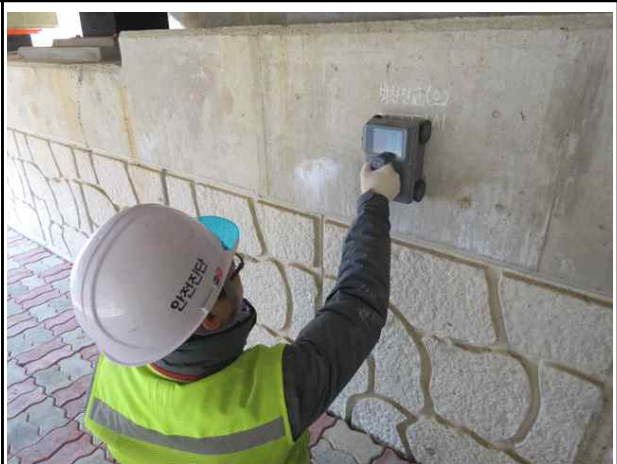
철근배근탐사 시험 전경
