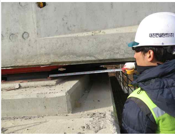
교량받침 연단거리 측정전경
