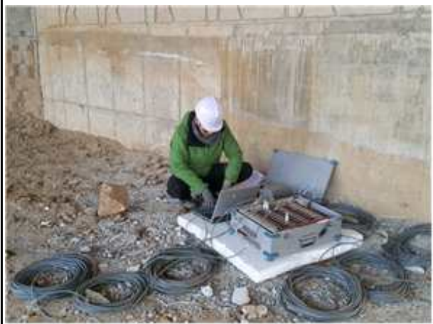
재하시험 계측 전경
