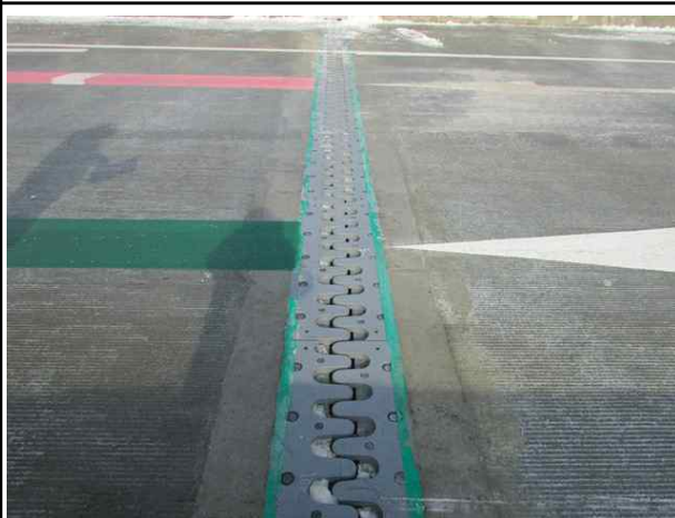
신축이음 상태양호(P3, 옥산방향)
