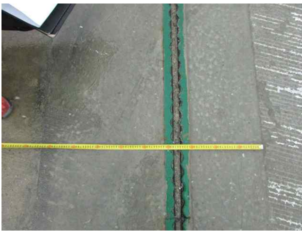
신축 유간거리 측정전경
