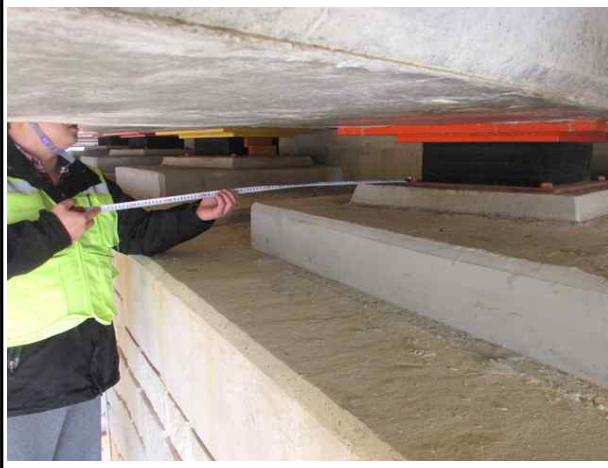
교량받침 연단거리 측정전경
