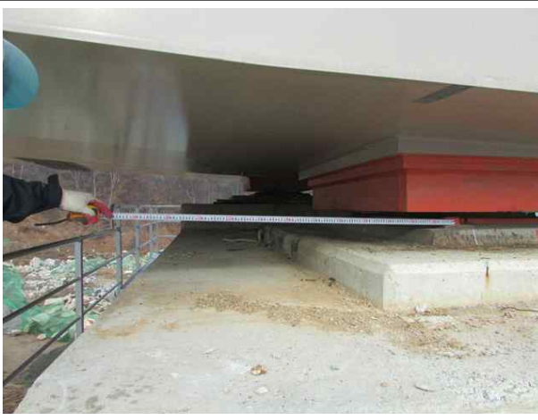
교량받침 연단거리 측정 전경
