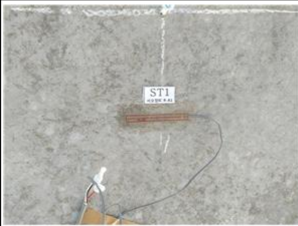
변형률계 설치 현황
