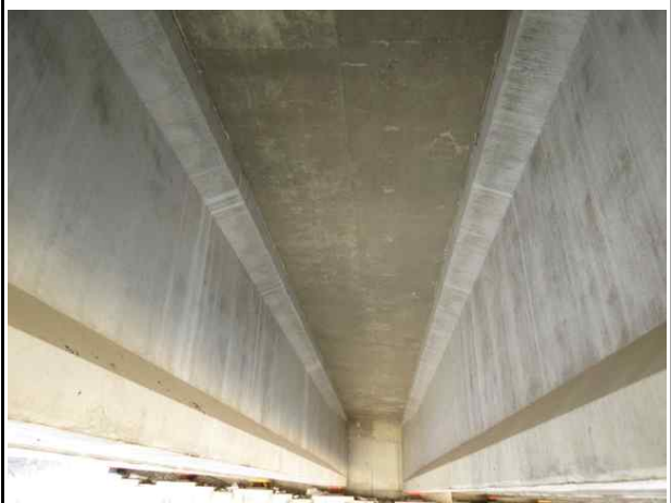
바닥판 하면 상태양호(옥산방향)
