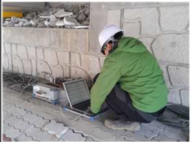
재하시험 계측 전경
