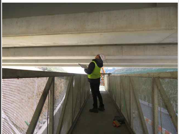
교량점검차를 이용한 바닥판 하부 조사
