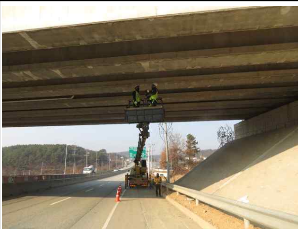
고소점검차를 이용한 바닥판 하부 조사
