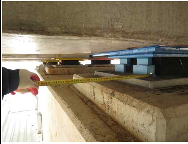
교량받침 연단거리 측정전경
