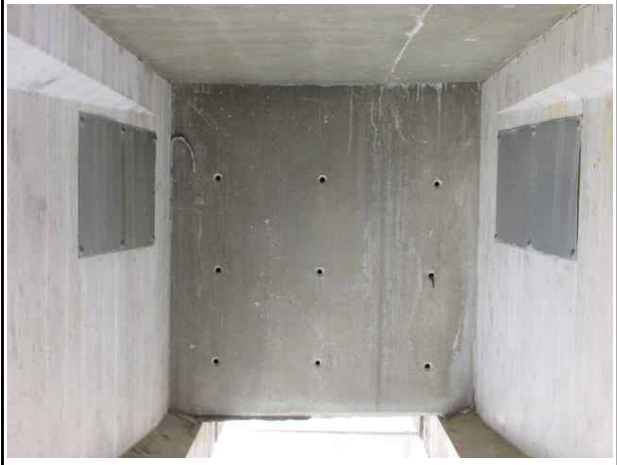
콘크리트 가로보 상태양호
