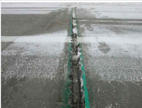
신축이음 상태양호(A1, 옥산방향)
