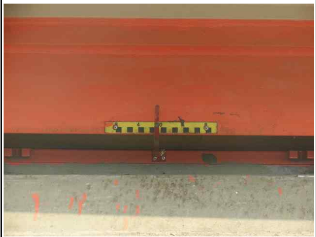
교량받침 이동량 측정 전경
