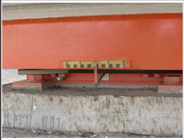
교량받침 이동량 측정 전경
