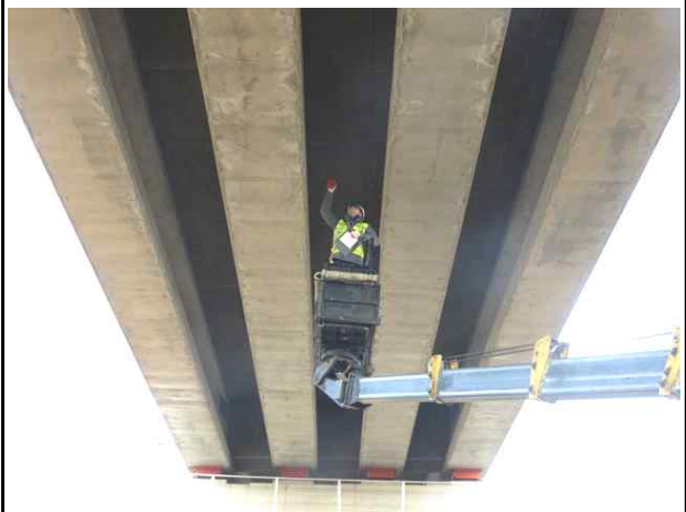
고소점검차를 이용한 바닥판 하부 조사
