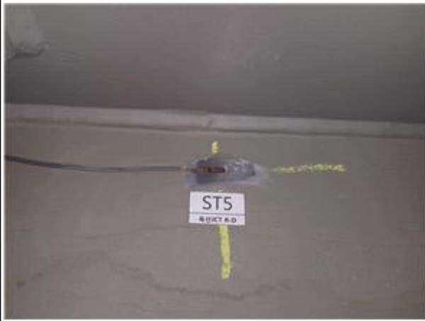
변형률계 설치 현황
