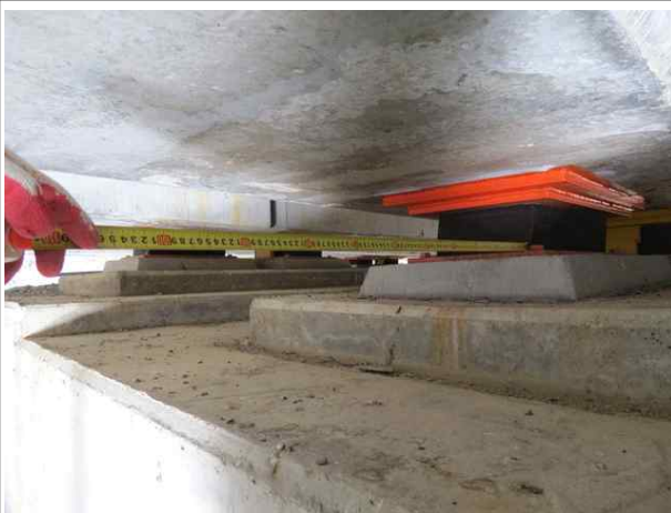
교량받침 연단거리 측정전경
