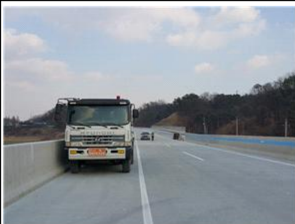
정적 재하시험 전경
