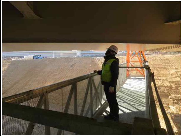
교량점검차를 이용한 바닥판 하부 조사
