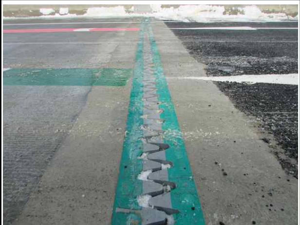
신축이음 상태양호(A2, 옥산방향)
