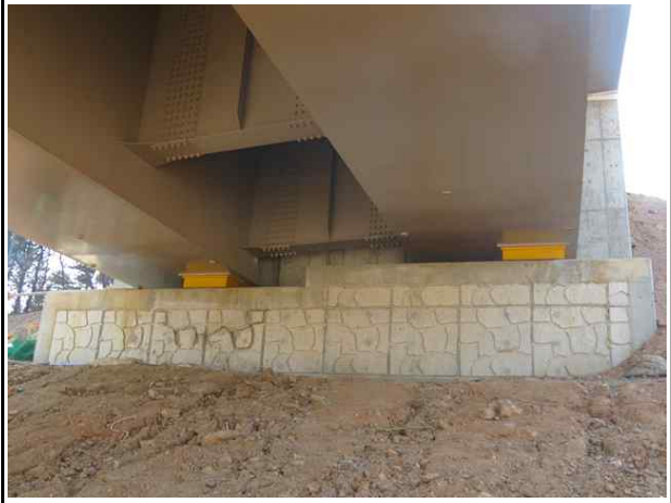
교대 A2 전경
