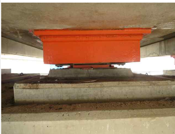
교량받침 상태 양호
