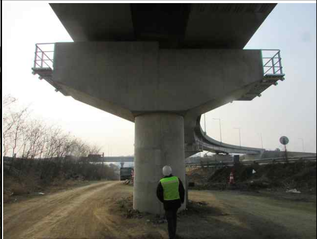
교각 P7 전경(상태양호)
