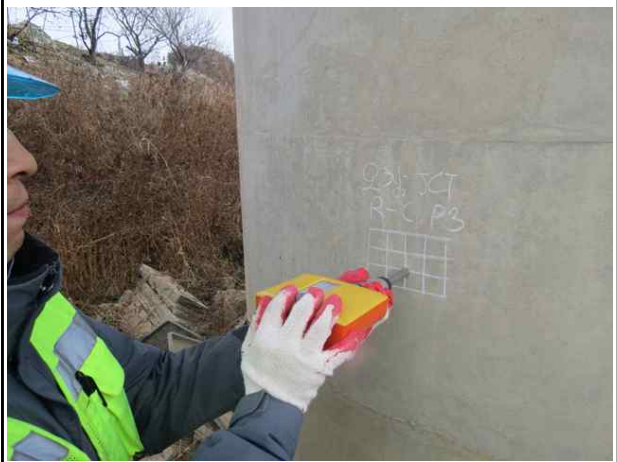
반발경도측정 시험 전경
