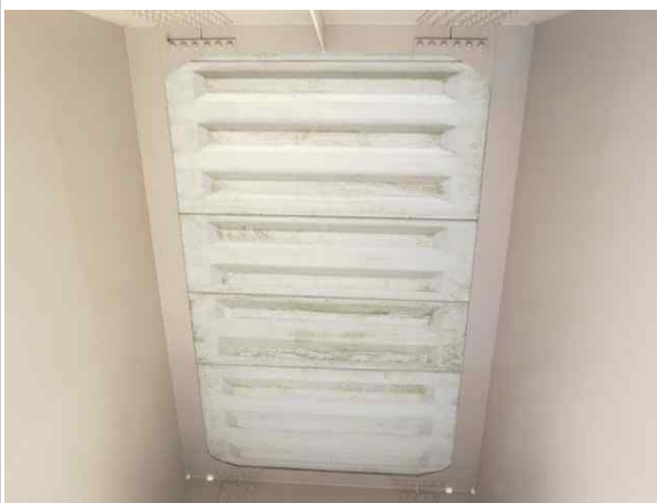
바닥판 중앙부 Rib Dek 상태양호
