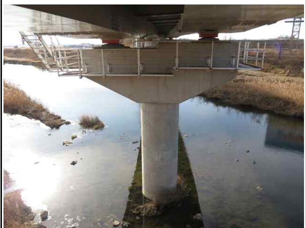
교각 P2 전경
