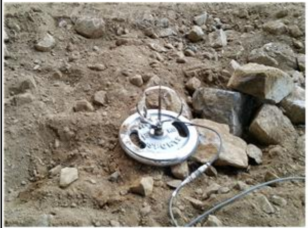
처짐계 설치 현황
