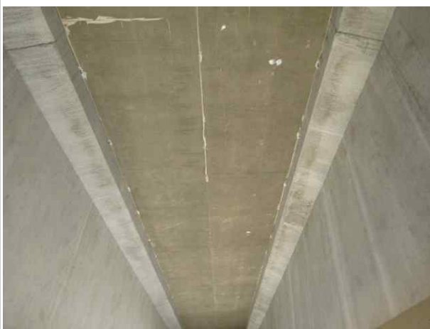
바닥판 하면 상태양호(옥산방향)
