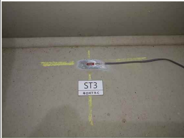
변형률계 설치 현황
