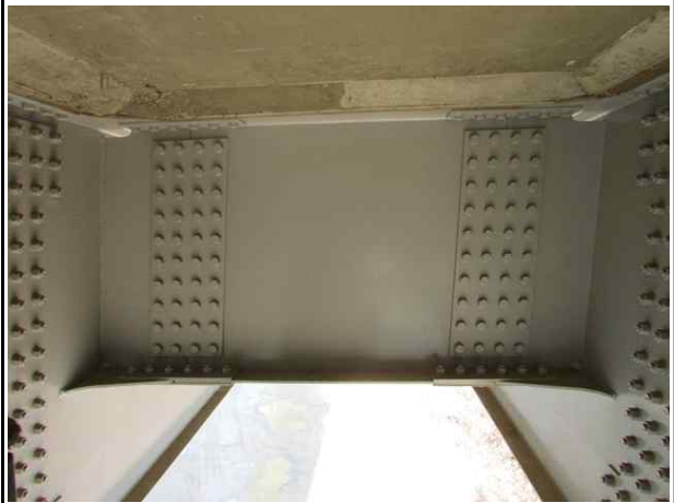
강재 가로보 상태양호
