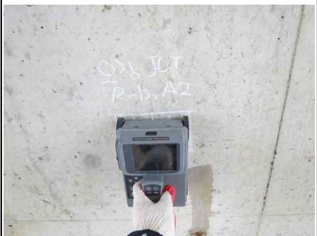
철근배근탐사 시험 전경
