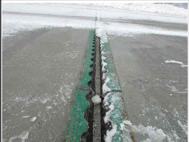
신축이음 상태양호(A2, 옥산방향)
