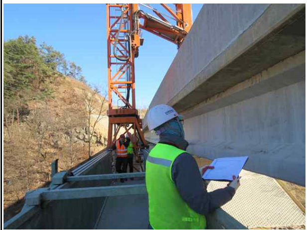
교량 점검차를 이용한 바닥판 하부 조사
