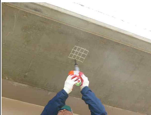
반발경도측정 시험 전경
