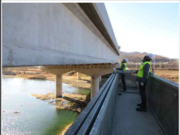
교량점검차를 이용한 바닥판 하부 조사
