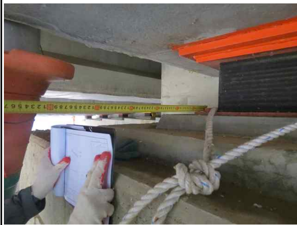
교량받침 연단거리 측정전경
