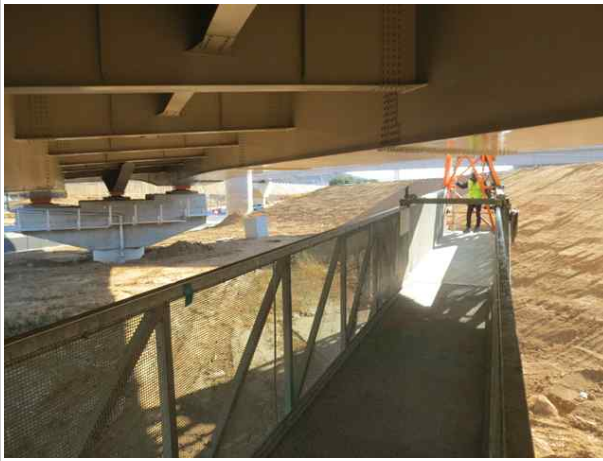
교량점검차를 이용한 바닥판 하부 조사
