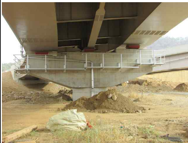
교각 P1 전경
