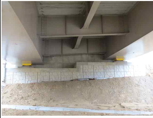
교대 A1 전경
