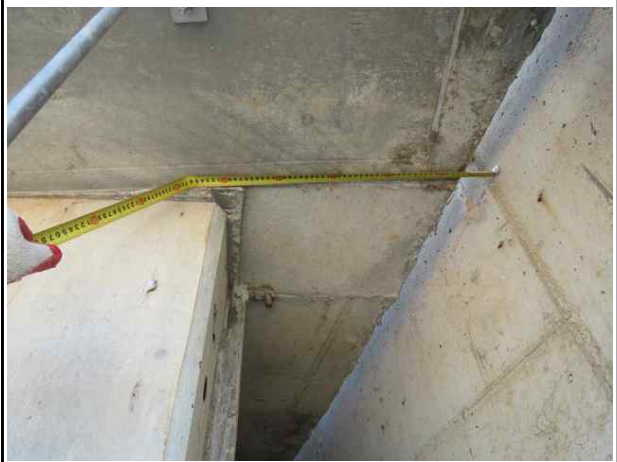
슬래브 유간거리 측정전경
