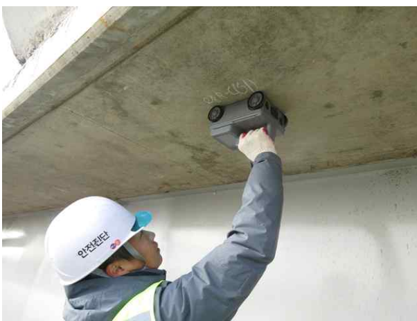
철근배근탐사 시험 전경
