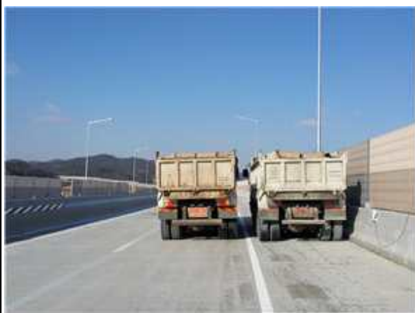
정적 재하시험 전경
