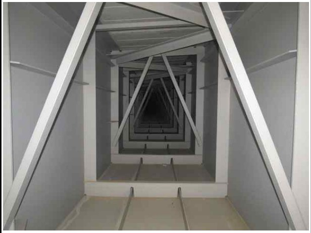
강재 거더 내부 상태양호
