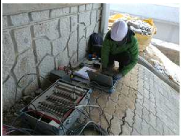
재하시험 계측 전경
