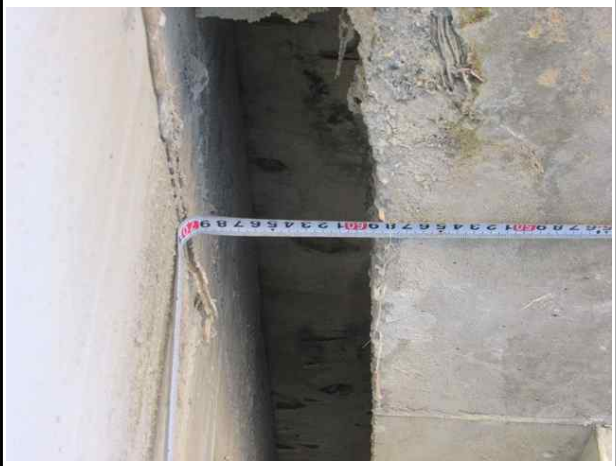
슬래브 유간거리 측정전경
