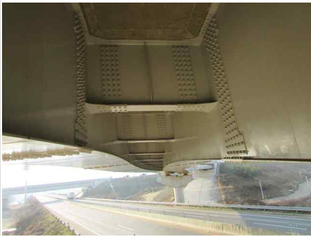
강재 가로보 상태양호
