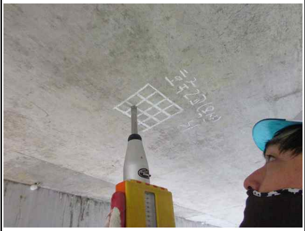
반발경도측정 시험 전경
