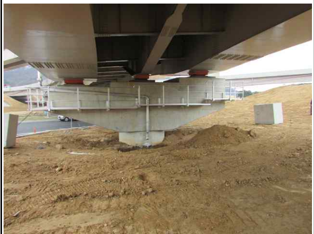
교각 P2 전경
