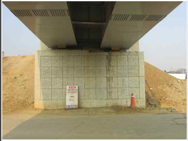
교대 A2 전경
