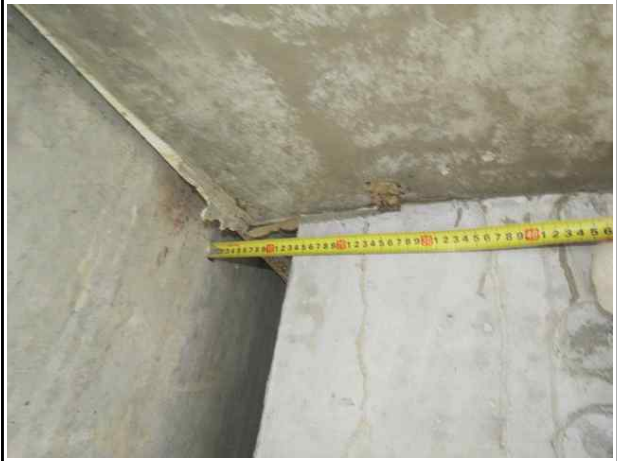
슬래브 유간거리 측정 전경
