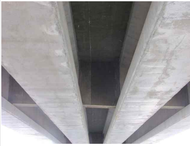
콘크리트 가로보 상태양호
