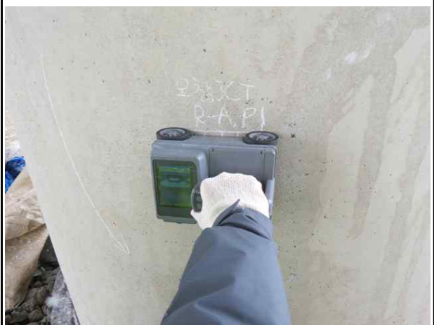
철근배근탐사 시험 전경
