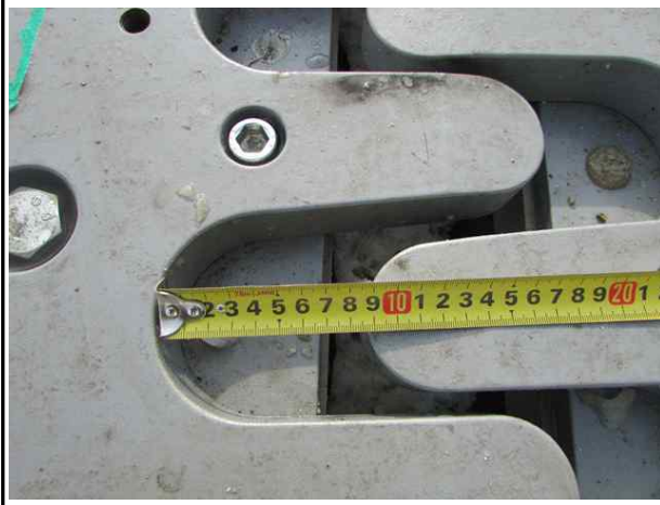
신축 유간거리 측정전경
