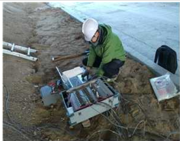
재하시험 계측 전경
