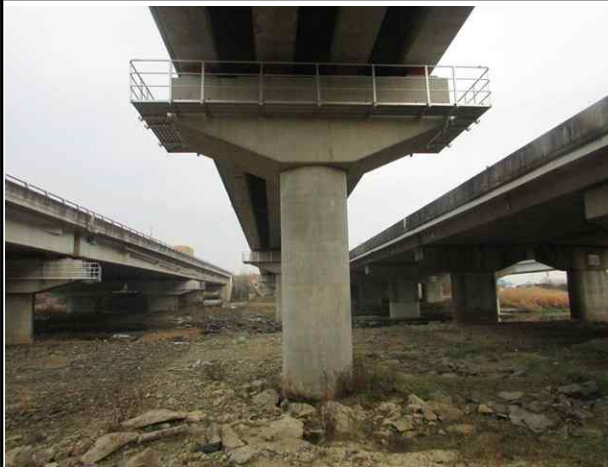
교각 P3 전경(상태양호)
