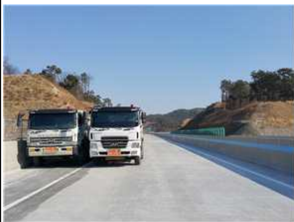
정적 재하시험 전경
