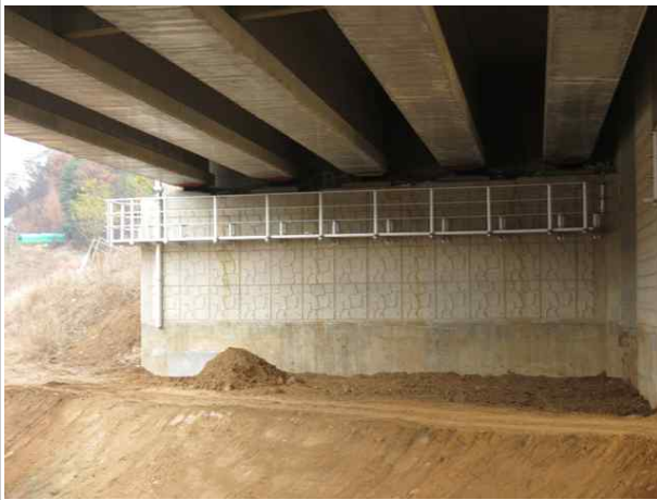
교대 A2(옥산방향) 전경(상태양호)
