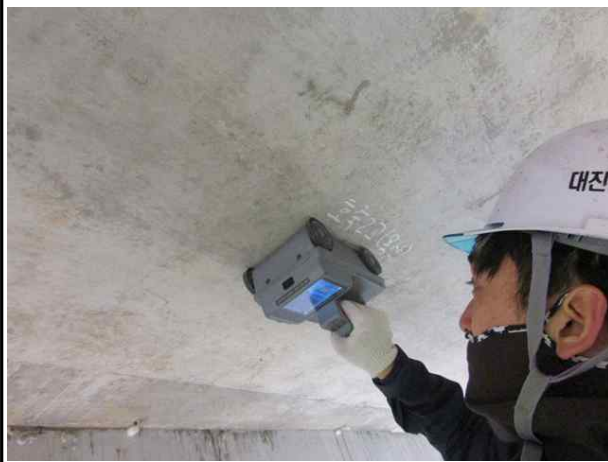
철근배근탐사 시험 전경
