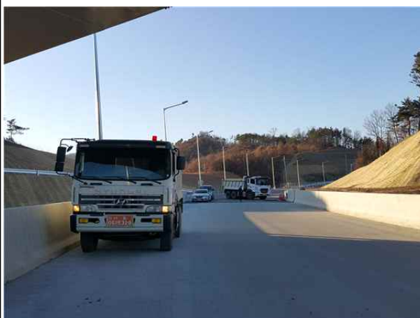
정적 재하시험 전경
