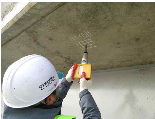
반발경도측정 시험 전경
