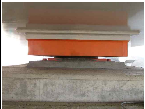
교량받침 상태 양호
