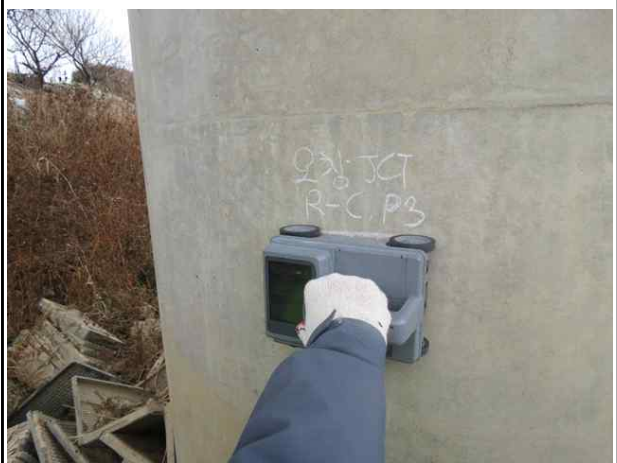
철근배근탐사 시험 전경
