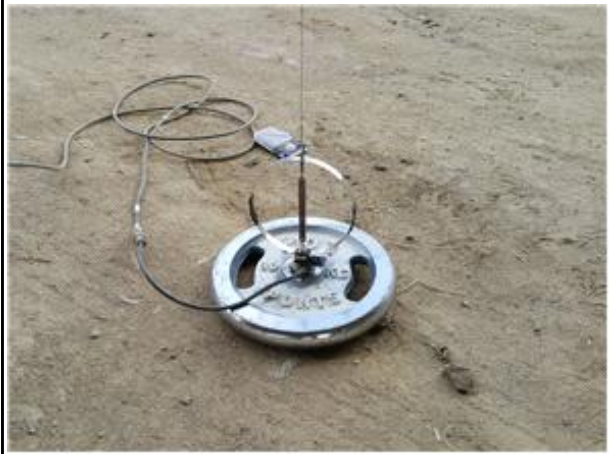
처짐계 설치 현황
