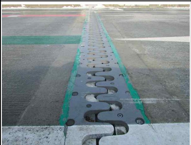
신축이음 상태양호(P3, 옥산방향)
