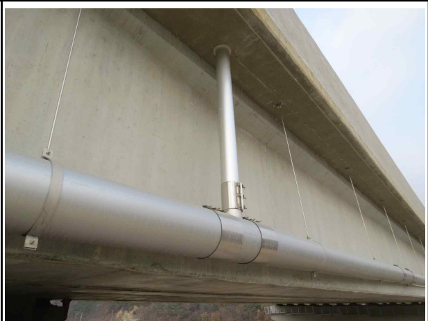
배수관 연결부 설치상태 양호(오창방향)
