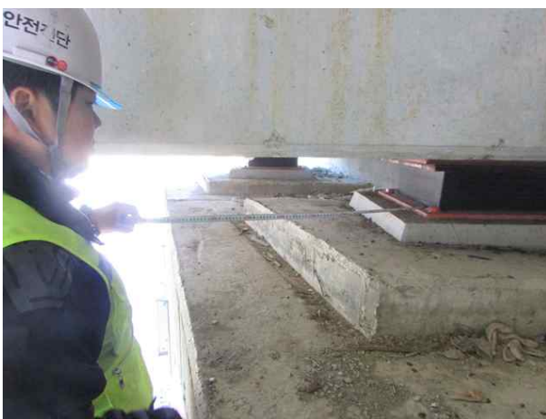
교량받침 연단거리 측정전경
