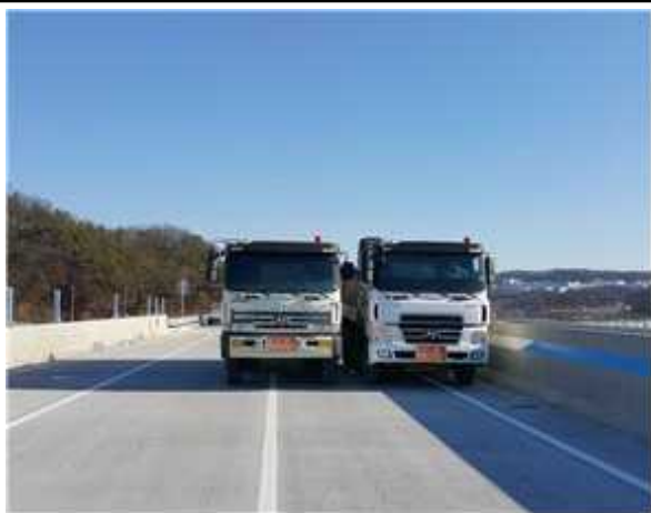
정적 재하시험 전경
