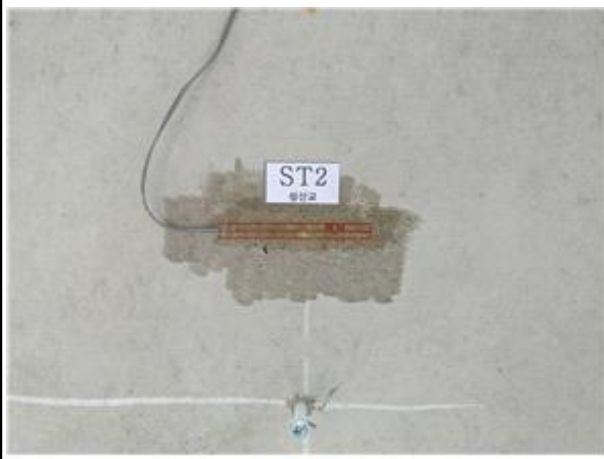
변형률계 설치 현황
