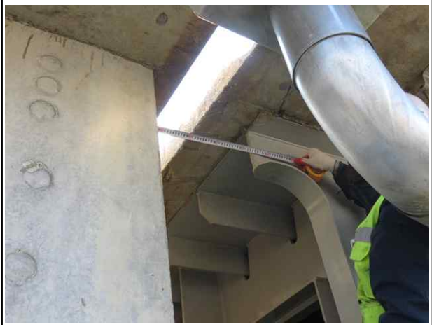
슬래브 유간거리 측정전경
