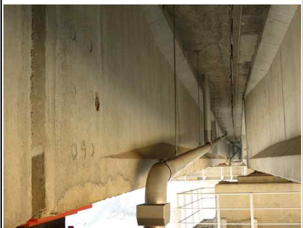
배수관 연결부 설치상태 양호(오창방향)
