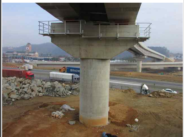
교각 P2 전경
