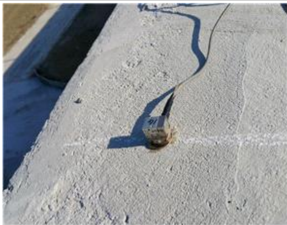
가속도계 설치 현황
