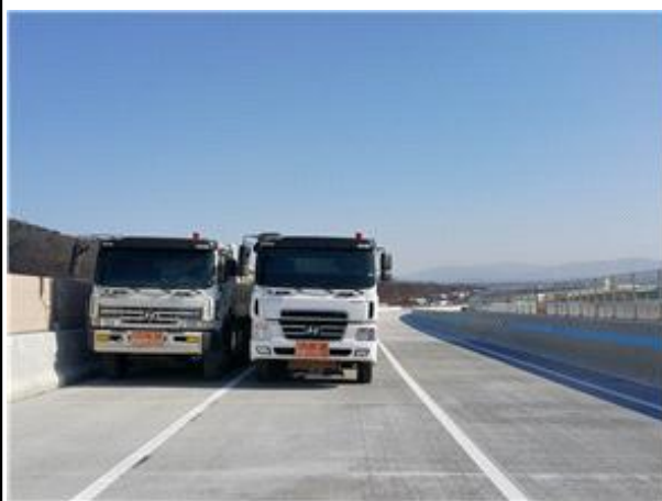
정적 재하시험 전경
